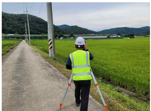
광파기를 이용한 경사도 측정
